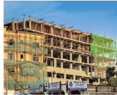
Links: Straßenbau in Kampala Rechts: Bau eines neuen Gebäudes in Kabalagala, in der Nähe von Kampala
